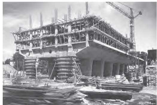
Figura 2 Construcción de l'Unité d'Habitation. (Gargiani y Rosellini 2011)
