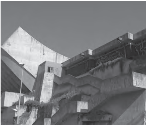
Figura 7 Estado actual de la Escalera de Acceso. (Autor 2017)
